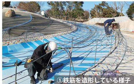
①鉄筋を造形している様子
